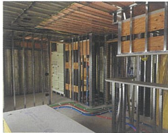
通電前の屋内作業に
